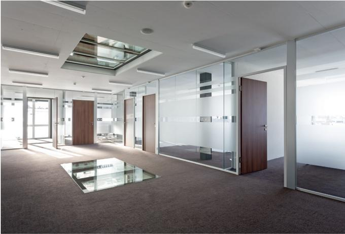
**Einsatzbereiche** Das System 300 eignet sich aufgrund seiner Konzeption als Ganzglaswandensystem für alle Einsätze als raumhohe Glaswandelemente insbesondere für Flurwände in Büroräumen. Sichtschutzelemente in Form von Folierungen, Sieb- oder Digitaldrucken können individuell aufgebracht werden. Sämtliche geometrische Anforderungen sind für Raumhöhen bis 3,60 m lösbar. Durch die Wahl unterschiedlicher Glasarten sind Schalldämmwerte bis 42 dB Rwp möglich.
