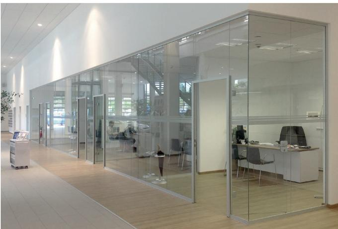
**Anschlüsse an den Baukörper** Die umlaufende Befestigung der Glastrennwand erfolgt mit Schraubverbindungen. Jeder Anschluss kann hierbei gleiten und Bautoleranzen bzw. Baubewegungen bis +/- 7 mm aufnehmen. Durch das Hinterlegen der Anschlussprofile mit Dichtbändern wird eine optimale Schallabdichtung zum Baukörper erreicht.
