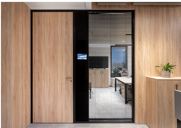
bandgegenseitig flächenbündiges Rohrrahmentürelement mit Oberlicht und T-Anschluss
